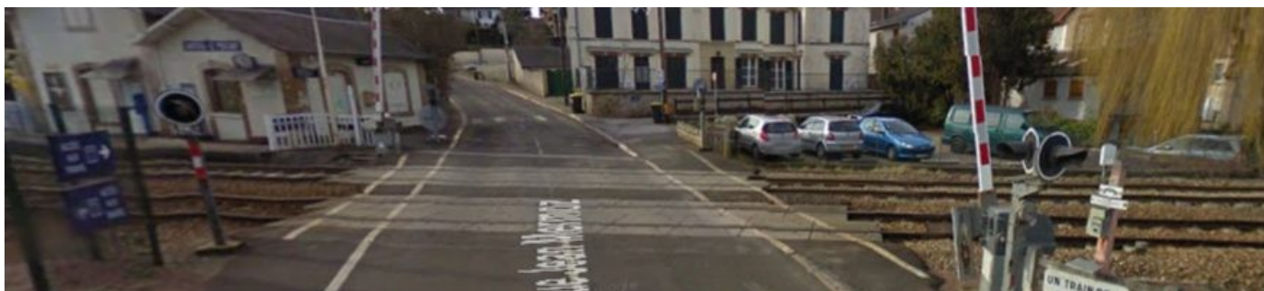
VISUEL N° 2 : Traversée de la voie ferrée au passage à niveau
