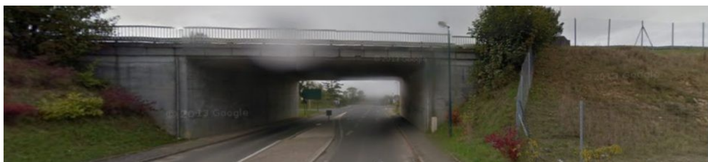
VISUEL N° 5 : Passage souterrain sous RD 169
